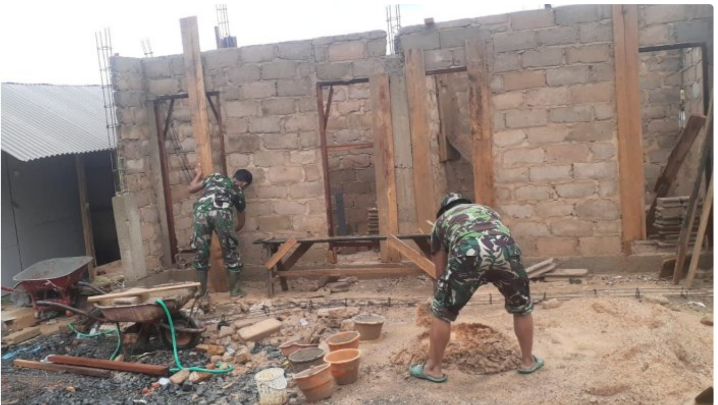
Satgas TMMD Ke 116 Kodim 1004 Kotabaru Genjot Pembangunan Tempat Wudhu Di Musholla
